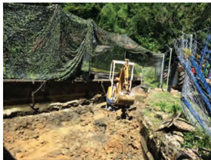
Aufzuchtbecken während dem Aushub.
